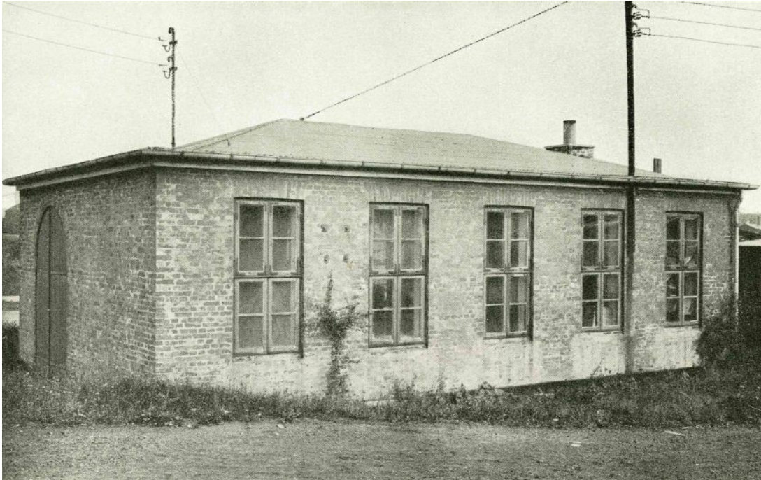
Savskærerbygning, Vigerslev Allé 160
