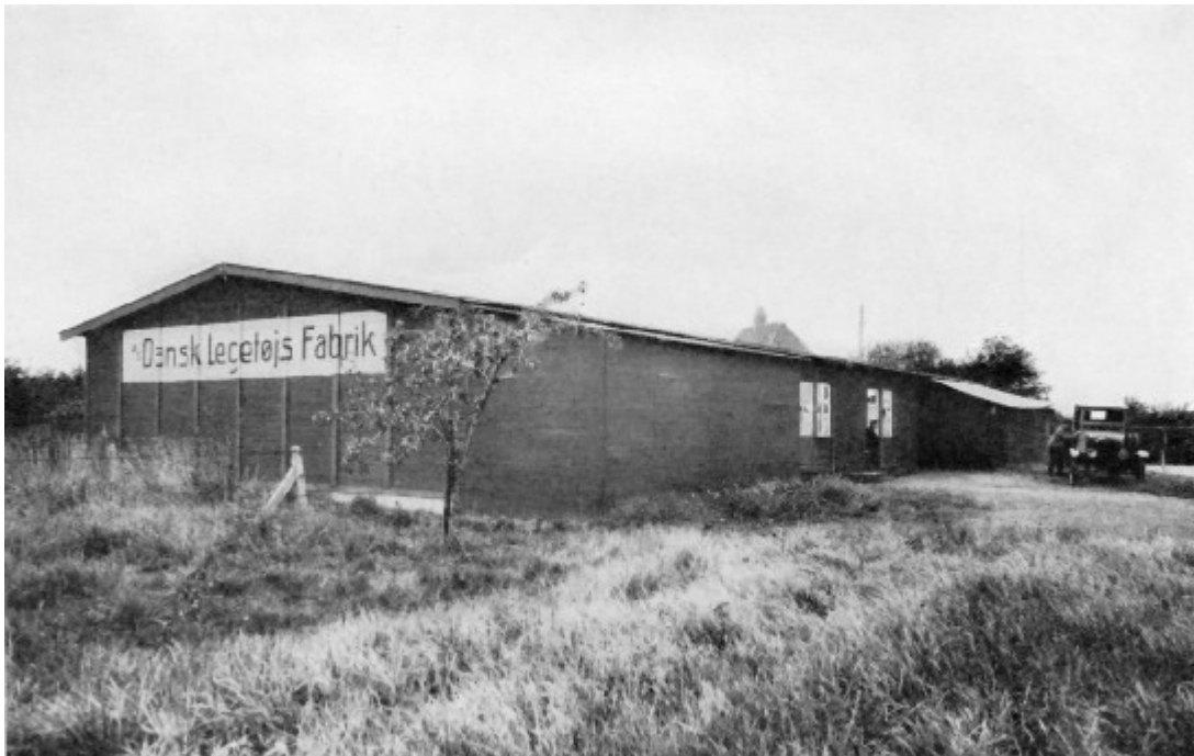
Lagerbygning, Vigerslev Allé 160
